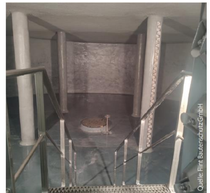
Bild 2: Wasserkammer nach Instandsetzung gemäß W 300
